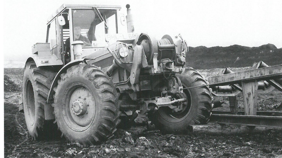
Sonderaufbau aus Marktoberdorf: Allrad-Schlüter im Dienst der damaligen Bayerische Braunkohlen Industrie AG mit FW 51-Winde im Frontanbau.
